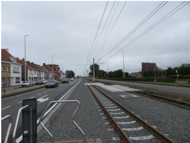
Foto 4: Rechterspoor op de foto is nog niet vernieuwd in de omgeving van de halte 'Zeebrugge kerk'.
